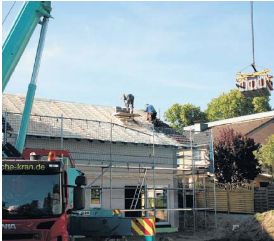
Kurz vor 19 Uhr wurden die Dachziegel gelegt. „Das Fertighaus schont unsere Nerven und die unserer künftigen Nachbarn“, meint Bauherr Dirk Podubrin. Lärm und Stress dauerten nur einen Tag. RP-FOTO: OLAF STASCHIK
